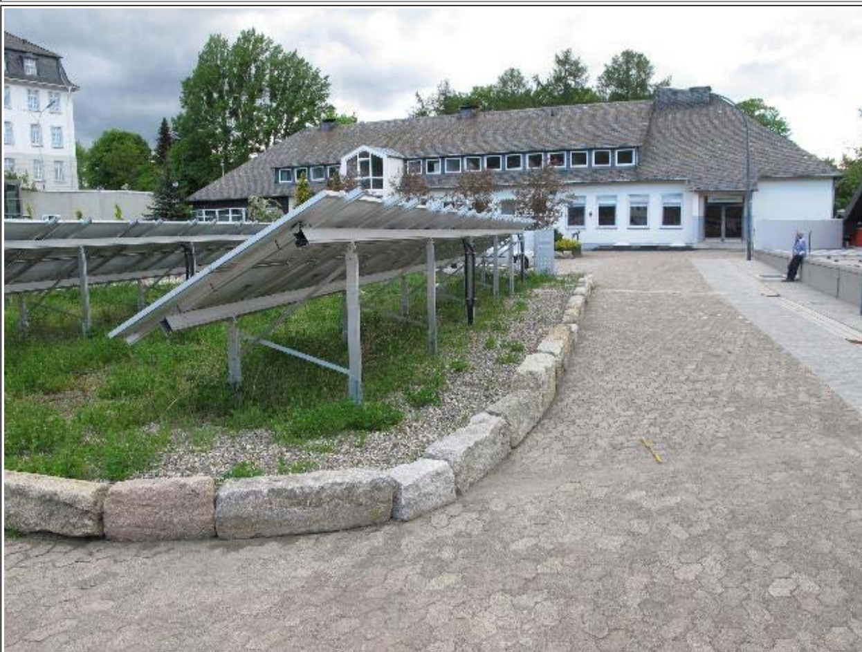
Abb. 02: PV-Kollektoren am Energieforschungszentrum in Goslar, sie speisen über Wechselrichter direkt ins Netz. Die Kollektoren sind von allen Seiten begehbar. Nach vorne zeigt der gelbe zwei-Meter-Maßstab, wie weit die spürbaren Effekte reichen. (FB)
