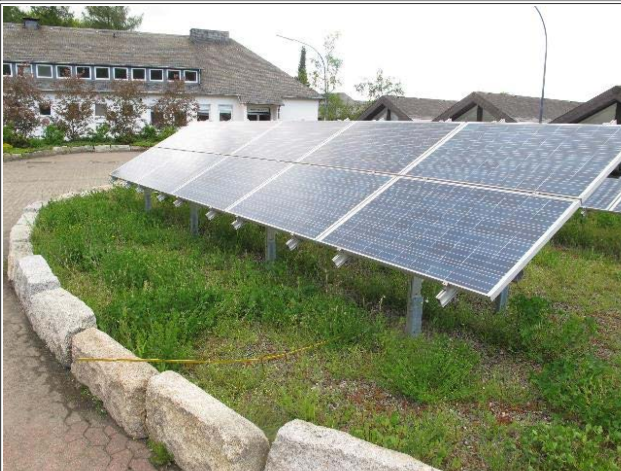
Abb. 02: PV-Kollektoren am Energieforschungszentrum in Goslar, sie speisen über Wechselrichter direkt ins Netz. Die Kollektoren sind von allen Seiten begehbar. Nach vorne zeigt der gelbe zwei-Meter-Maßstab, wie weit die spürbaren Effekte reichen. (FB)
